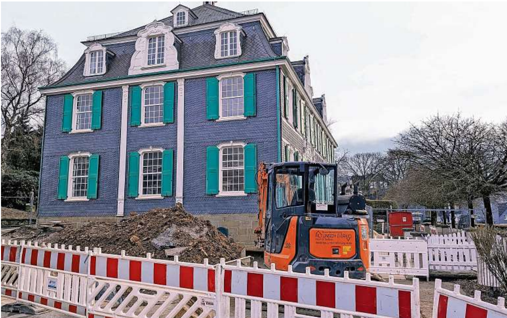
Aktuell werden auch die Zuwegungen zum Haus Cleff erneuert.
