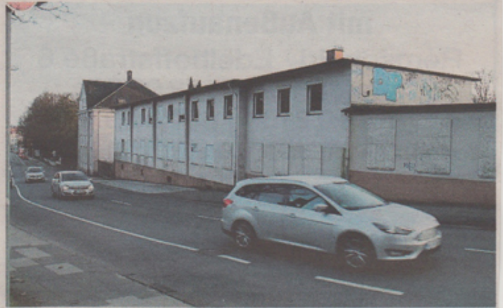
Soll bald wieder mit Leben gefüllt werden: das leerstehende Gebäude Honsberg Lamb an der Hastener Straße. Foto: René Großmann
