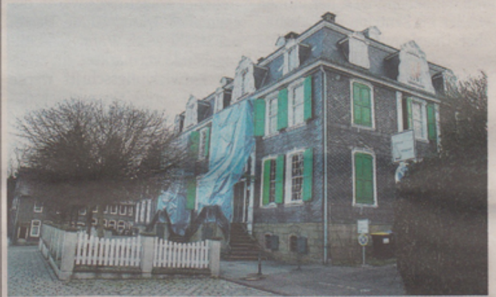
Was sich im Haus Cleff tut, können interessierte Bürger bei den Baustellenführungen erfahren. Foto: René Großmann
