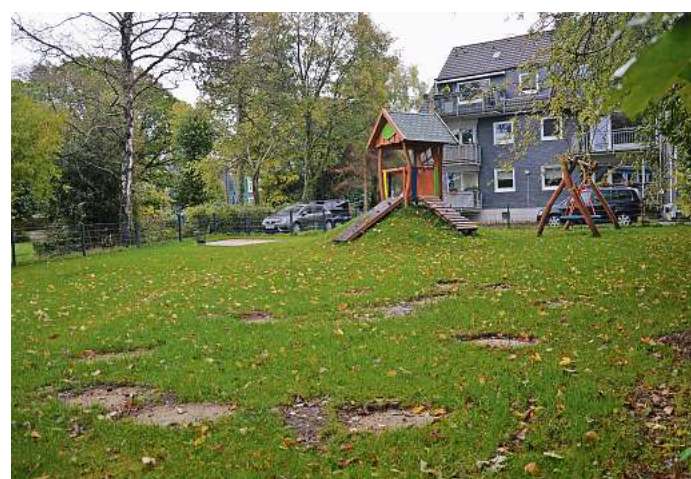
Die Fundamente im Vordergrund lassen erkennen, wie groß die hölzerne Kletter-Kirche wird. Foto: Katharina Birkenbeul
